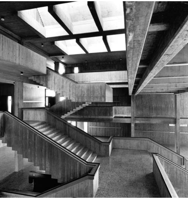
6 Realschule Lemgo, offene Treppenanlage im Pädagogischen Zentrum. Foto 1969.
