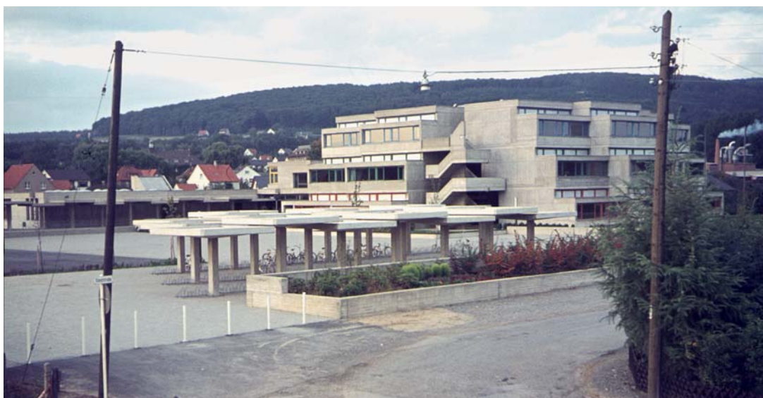
2 Realschule Lemgo von Südwesten mit den terrassierten Klassenräumen, im Vordergrund der Fahrradständer mit Stahlbeton-Pilzdächern. Foto 1970.
