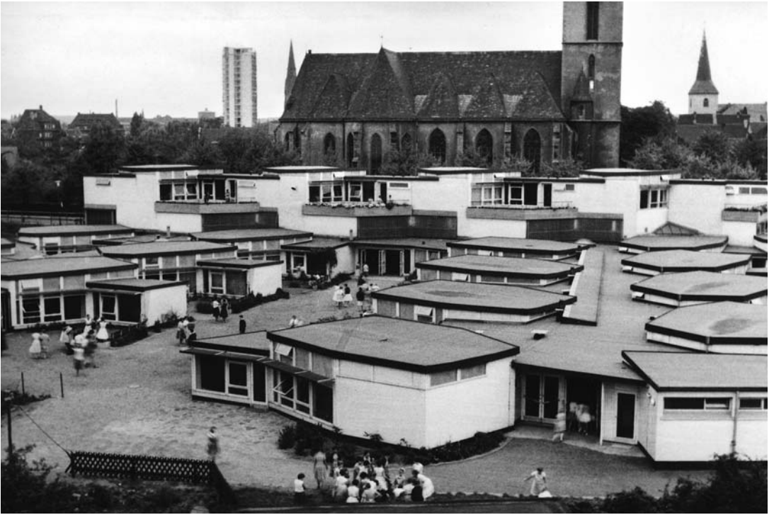
1 Hans Scharoun gehört zu den wichtigsten Protagonisten des dezentralen Schulbaus der 1950er-Jahre. Hier die 1956–1962 erbaute, inzwischen denkmalgeschützte Geschwister-Scholl-Schule in Lünen mit ihren Klassenpavillons. Foto um 1969.
