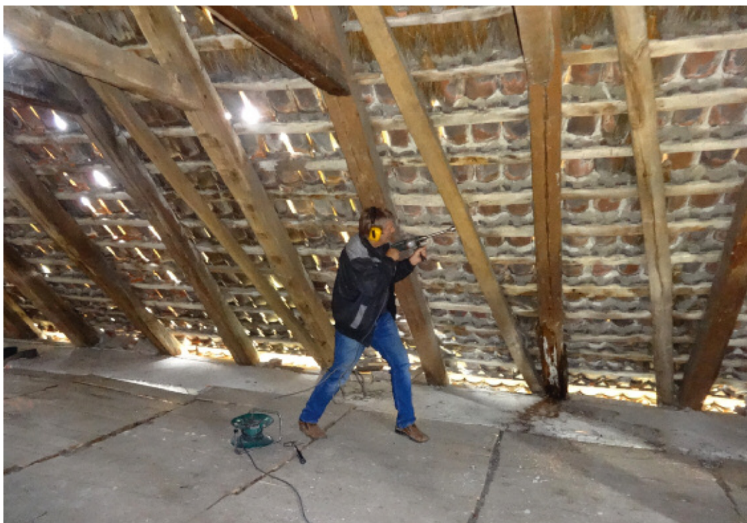
5 Entnahme einer Holzprobe aus einem Sparren von einem Dachwerk zur dendrochronologischen Untersuchung durch die Bauforschung der DLBW. Foto 2014.
