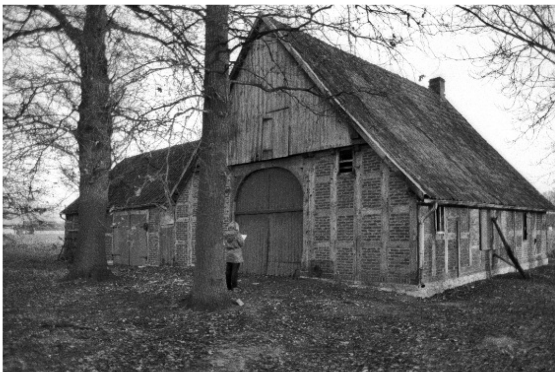
1 Denkmalpflegerin bei der Schnellinventarisierung 1983 vor einem Kötterhaus bei Steinhagen-Brockhagen, Kreis Gütersloh.
