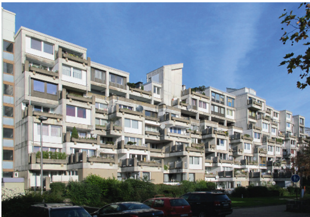
3 Bochum, Terrassenwohnhaus Gironde, Albin Hennig, Dieter Dietrich, 1967–1971. Ein bedeutendes Beispiel der in dieser Zeit entstandenen, für die Denkmalpflege nicht immer einfach vermittelbaren baulichen Großstrukturen.
