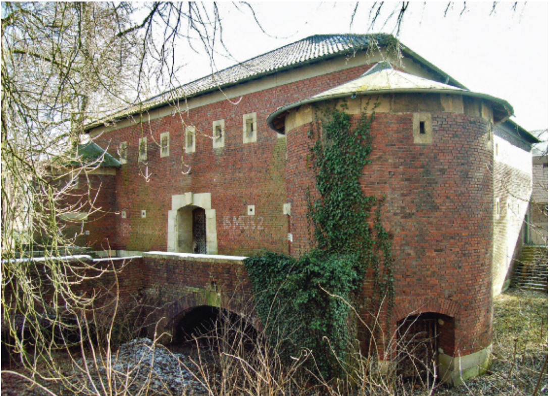
2 Luftschutzbunker, Lazarettstraße, Münster. Dreigeschossiger Betonbau mit Walmdach und zwei niedrigen Rundtürmen. Foto 2010.
