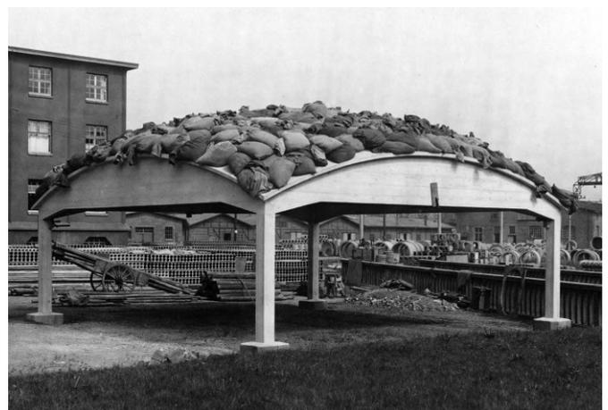
**Bild 9** Probelastung der Versuchsschale mit Sandsäcken; solche unspektakuläreren Versuche lieferten die eigentlichen Daten [20]
