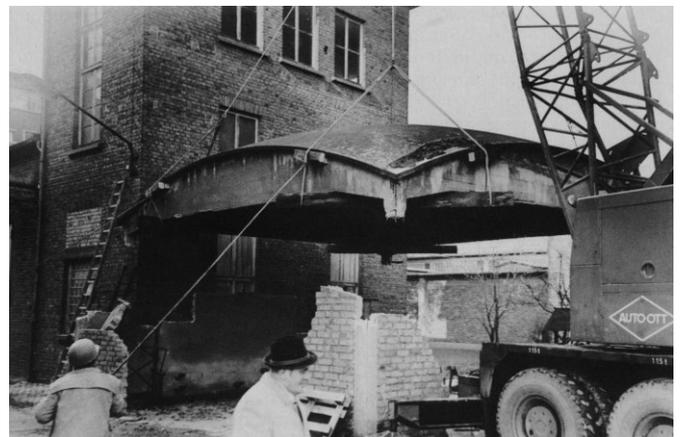
**Bild 12** Erste Translozierung: Abheben der Schale von den abgetrennten Eckstützen in Biebrich, 1974 [30]
