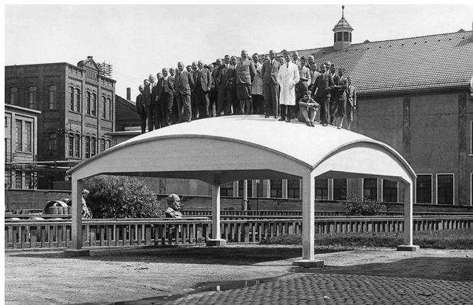
**Bild 1** Dywidag-Versuchsschale von 1931, Probelastung mit Mitarbeitern von Dyckerhoff & Widmann am 17. August 1931 als Schauversuch; diese Abbildung wird wegen ihrer ikonischen Bildwirkung bis heute immer wieder reproduziert [1]
