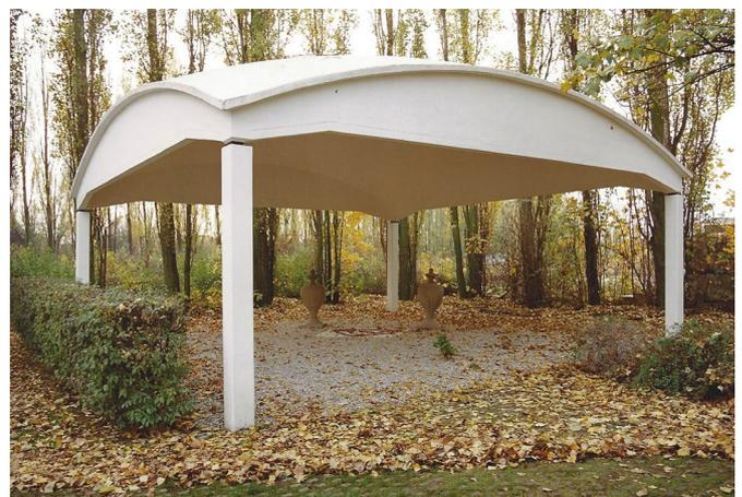
**Bild 13** Die Versuchsschale an ihrem zweiten Standort auf dem Firmengelände von Dyckerhoff & Widmann an der Berliner Straße in Wiesbaden-Erbenheim, Zustand nach der Sanierung 1990 [31]
