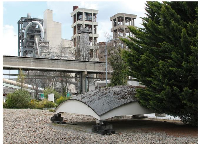
**Bild 14** Die Versuchsschale an ihrem heutigen, dritten Standort auf dem Gelände des Zementwerks Dyckerhoff in Wiesbaden-Amöneburg, 2016: Die Schale ist provisorisch gelagert, ohne die Eckstützen aus dem Jahr 1974 [Foto Verfasser]
