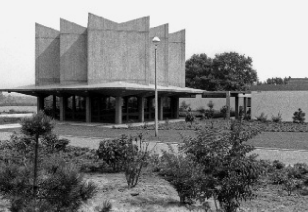
1 Bochum, Baukomplex Trauerhalle Ost, Außenansicht der Trauerhalle (im Hintergrund Betriebsgebäude und Leichenzellentrakt). 1976.
