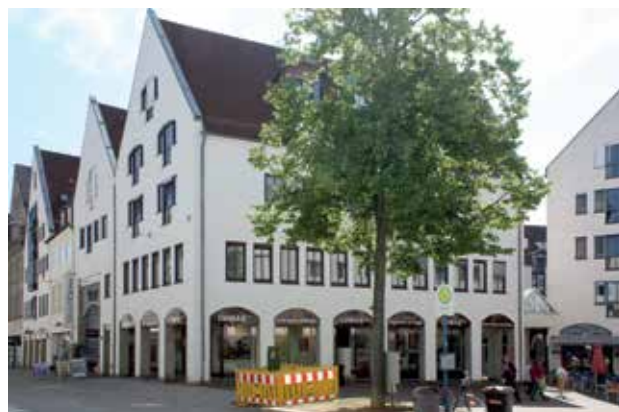
18 Bielefeld, Obernstraße 23–25, Neubauten des „Altstadt Carrees“, Martin – Lausberg – Wollenburg Architekten (Bielefeld), 1985–87. Prägend für die Architektur sind zum Beispiel die giebelständige Ausrichtung und die Arkaden des Eckgebäudes. 2014.
