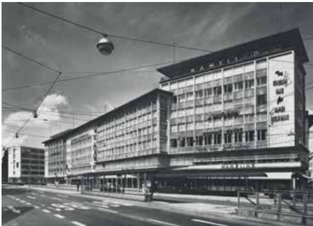
14 Bielefeld, Alfred-Bozi-Straße/Jahnplatz, repräsentative Geschäfts- und Verwaltungsgebäude in zeitgenössischen Formen, erbaut 1955–63. Um 1967.
