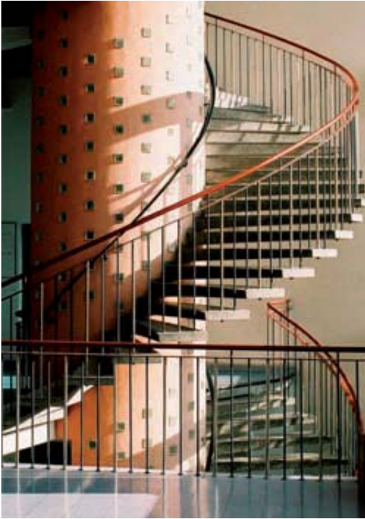
23. Wendeltreppe mit rotem Betonkern. Foto: Knut Stegmann, 2005.
