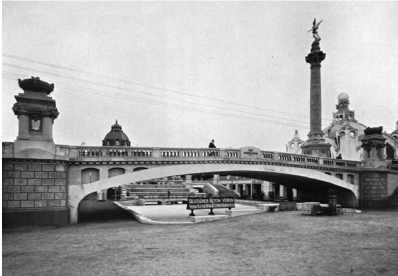
Abb. 2: Brücke auf der Gewerbeausstellung in Düsseldorf 1902, ausgeführt von Dyckerhoff & Widmann, Entwurf A. Bender, W. Fränkel, Düsseldorf
