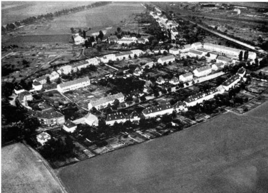
21 Köln-Gremberghoven, Eisenbahnersiedlung, Luftaufnahme Kernsiedlung, 1953
